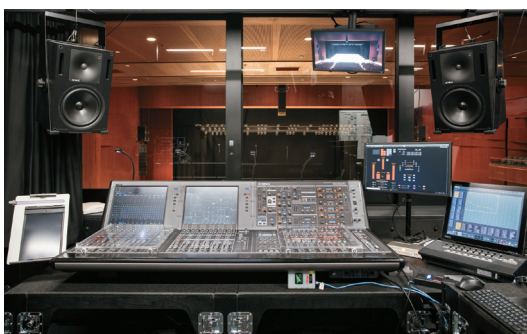
▶大劇場のコンソールにはYAMAHA RIVAGE PM7が採用されている。その右隣には、マトリクス・コントローラーのHYFAX LDM1を設置。モニター・スピーカーはGENELEC 1032Bだ
